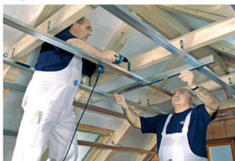
Montáž podkonstrukce – připevnění pomocí krokrových závěsů
