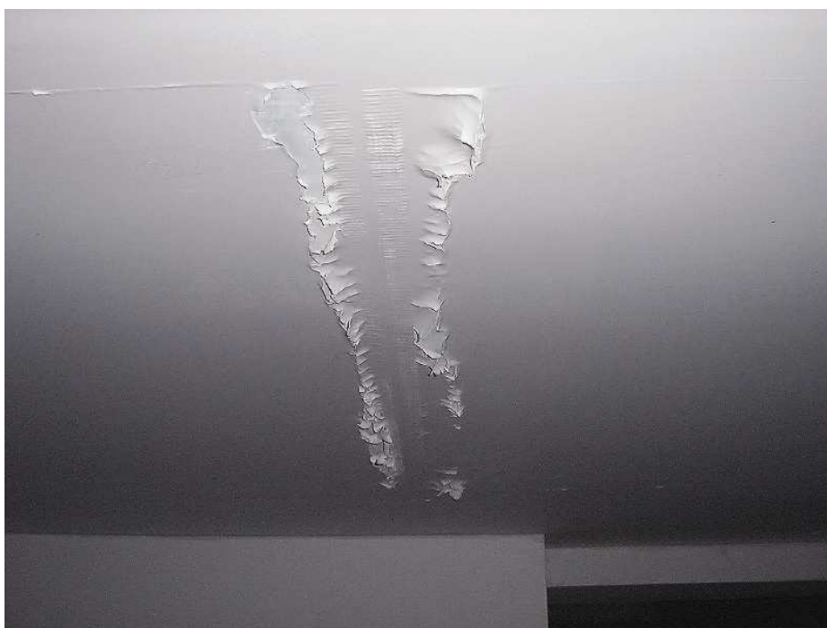
Obr. 3: Delaminace papíru ze sádrokartonové desky působením vody
